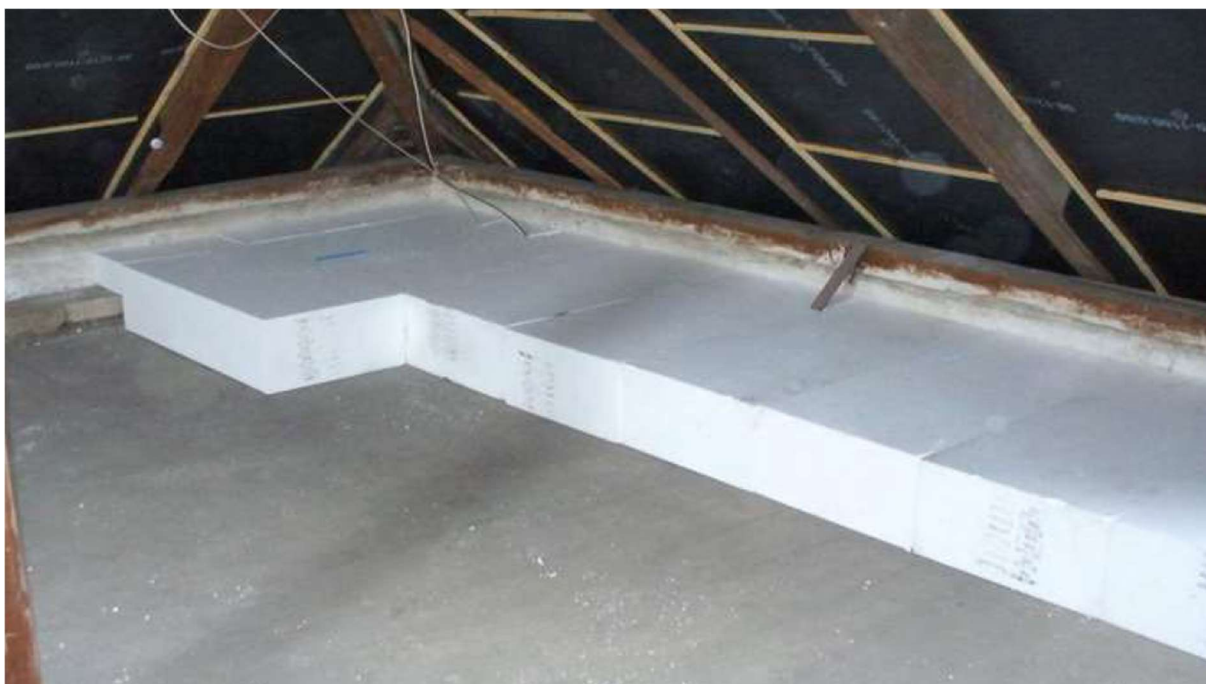
Obrázek 4.1.3: Systém zateplení stropní konstrukce (Zdroj: nejremeslnici.cz)
